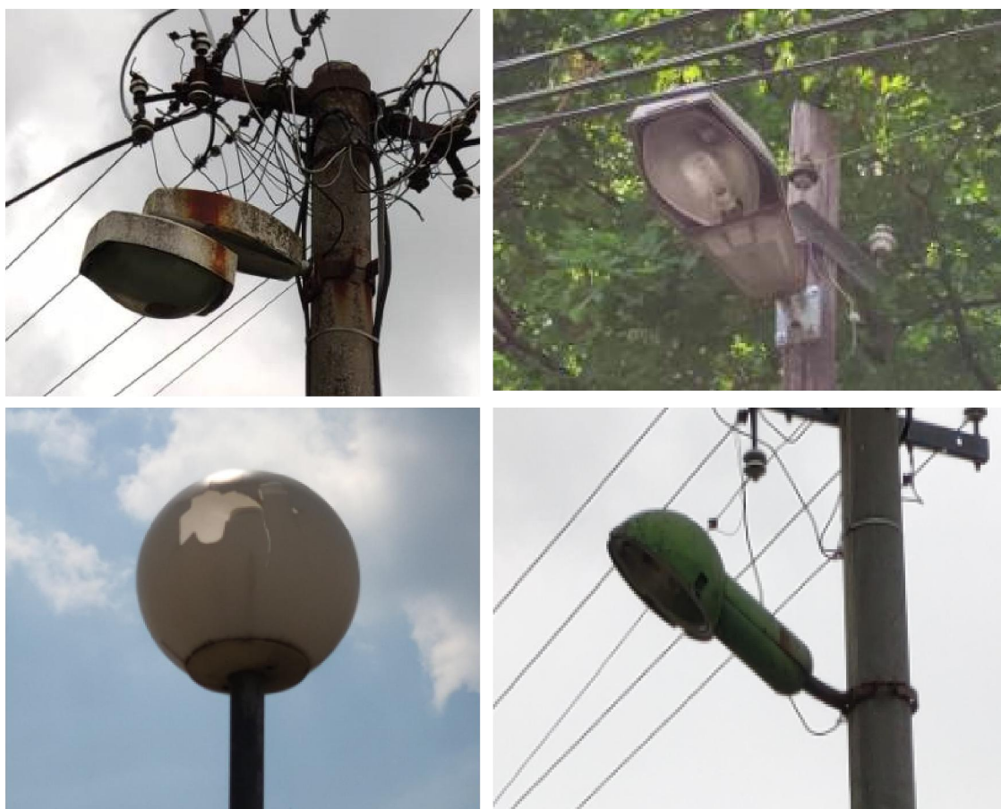
Obr. 3 Fyzicky opotrebované svietidlá typu "Ambasador" / "KZ" / "Globe mlieč" / "HRU", prekročené hranice životnosti svietidiel
