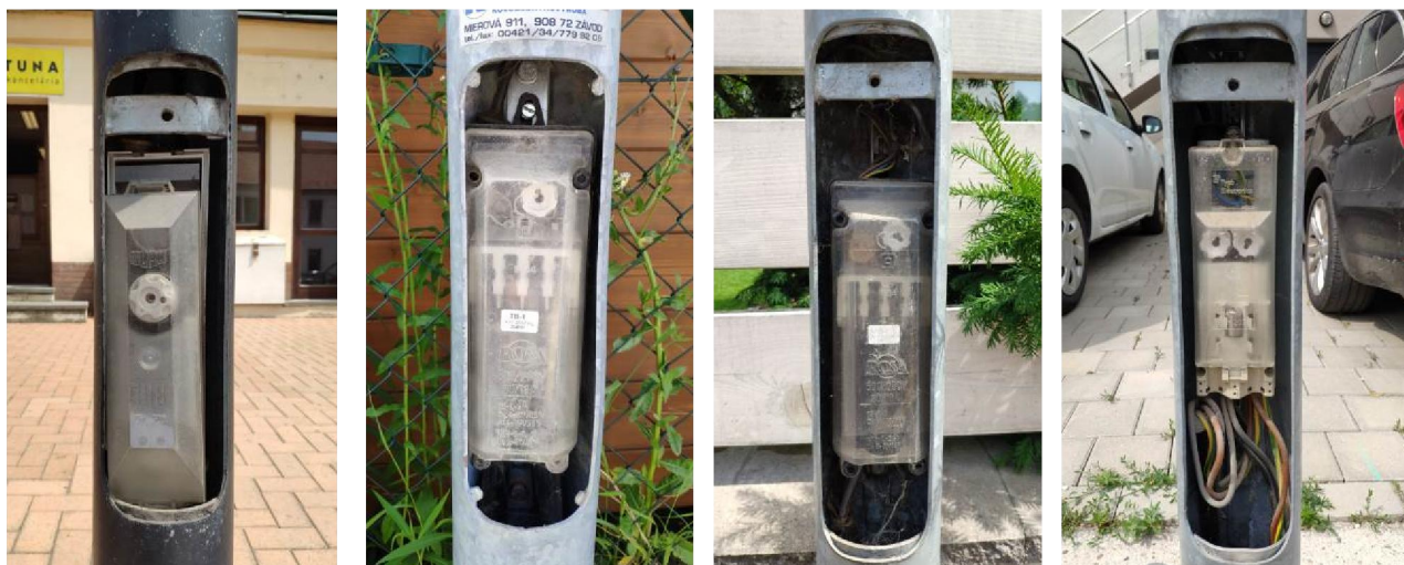
Obr. 13 Stožiarové svorkovnice vo vyhovujúcom stave – Hlavná Ulica (pešia zóna), Matušková, Sama Tomašika
