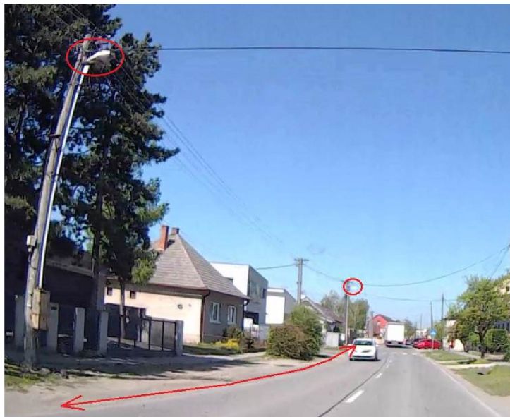
Obr. 17 Veľké rozostupy medzi svietidlami – vzdialenosť okolo 60 - 65 m medzi stožiarmi - Ulica Ferdiša Kostku
