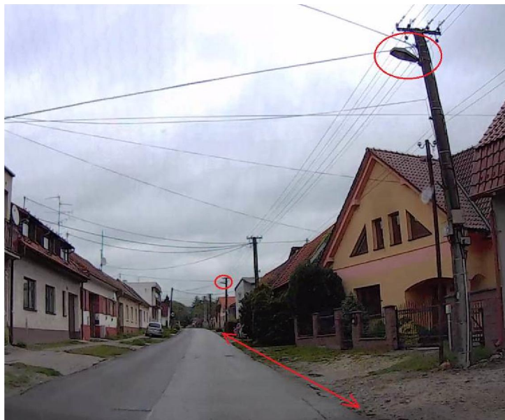
Obr. 18 Veľké rozostupy medzi svietidlami – vzdialenosť okolo 60 - 65 m medzi stožiarmi - Ulica Nová
