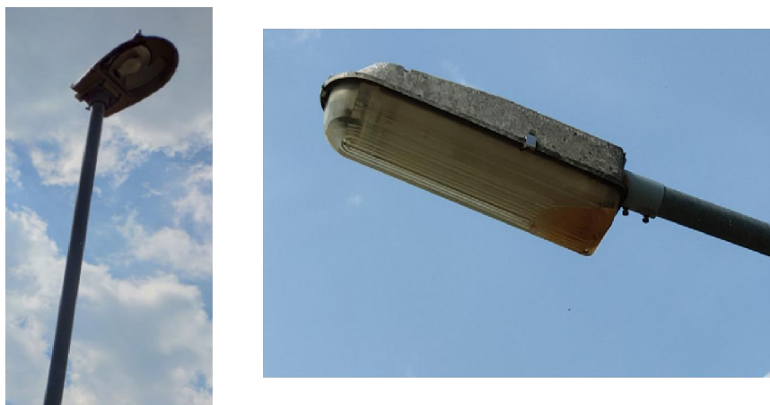
Obr. 2 Najrozšírenejšie svietidlá v sústave typu "Malaga" a "AT" znečistenie a korózia svietidla, materiálne opotrebovanie
