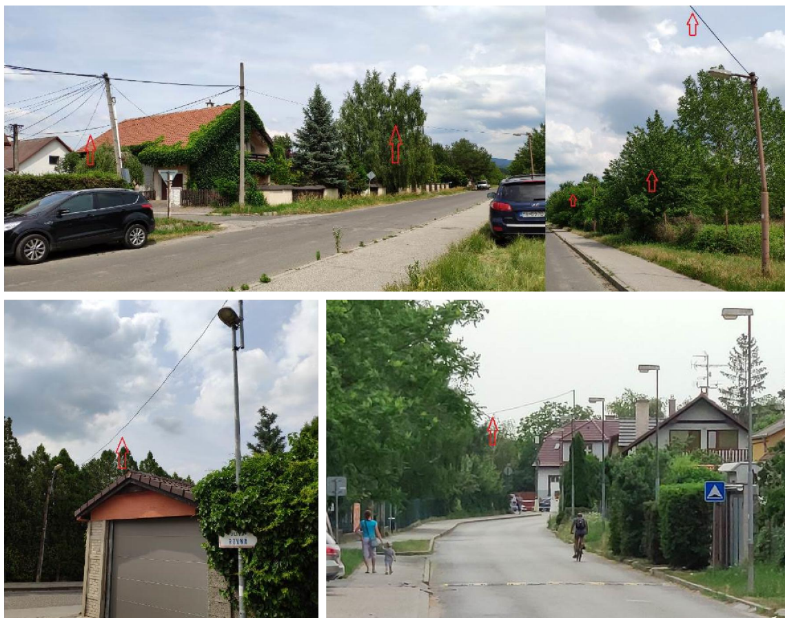
Obr. 15 Svetidlo na oceľovom stožiar napájané izolovaným vodičom – Železničná / Rovná / Školská
