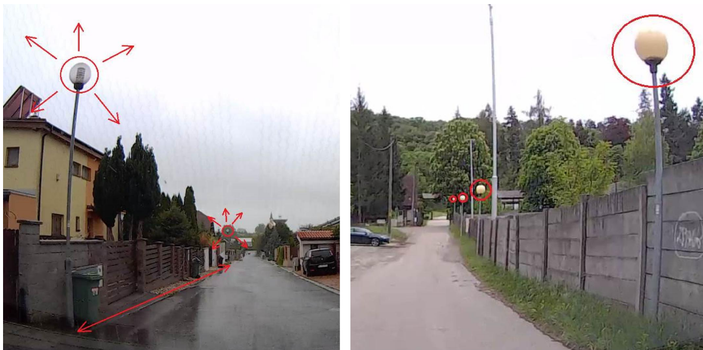
Obr. 19 Svietidlo typu „Globe“ – svietidlo nesvietí na miesto, kam by malo / veľká vzdialenosť medzi svietidlami Ulica Sadová / pri Ulici Nová
