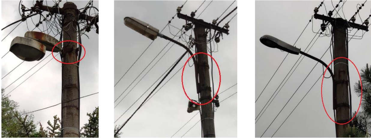
Obr. 7 Svietidlo typu "Ambasador", "AT" a "Po" – Ulica Nová Skorodovaný, nepevný výložník
